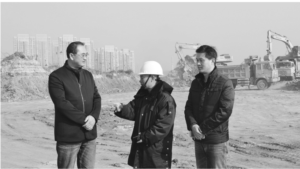
工地负责人介绍新能源汽车产业园建设进展
