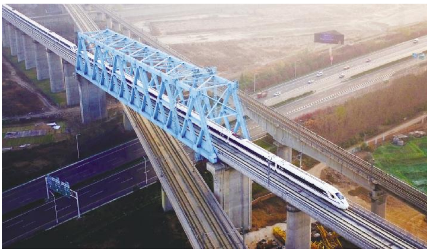
12月6日，西成高铁由西安北站驶出的列车经过西成高铁跨西宝高铁特大桥，该桥是出西安北站的第一座特大桥。新华社记者 刘满摄
